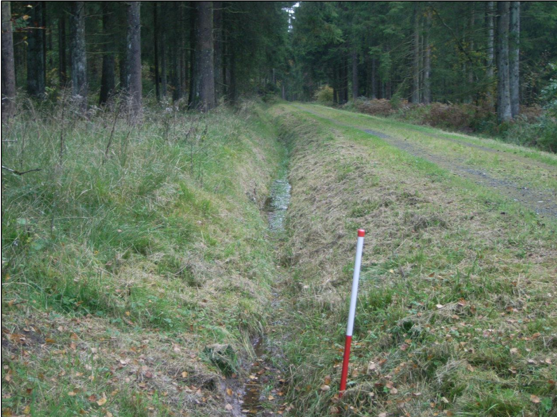
Abb. 24: Wegeseitengraben mit Entwässerungsfunktion für den linksseitigen Hangbereich; eigene Aufnahme (2017)
