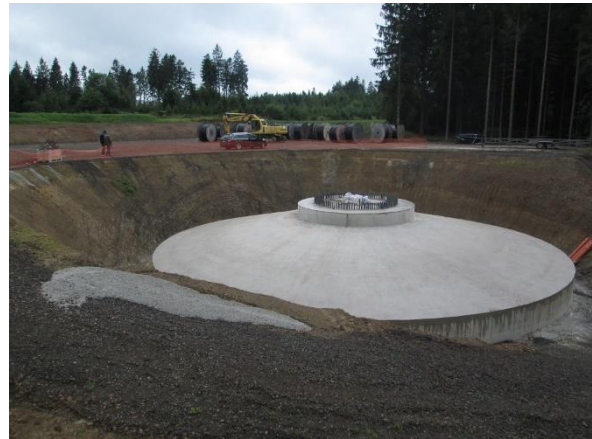
Fundament Windkraftanlage ca. 3.500 to Stahlbeton Durchmesser ca. 35 m ©BI Gegenwind-Schneifel
